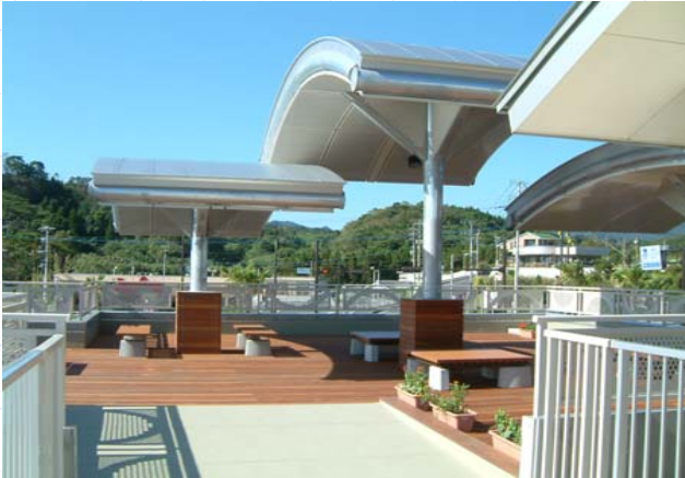
トイレ屋上展望台
