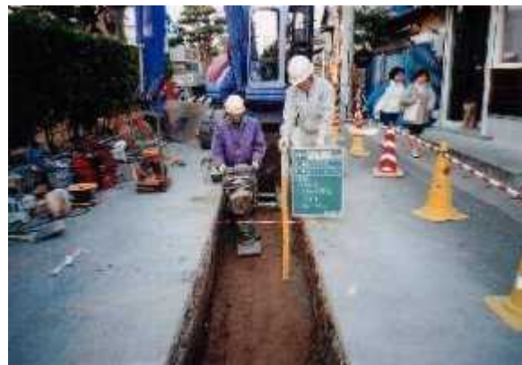
改良土の埋め戻し状況
