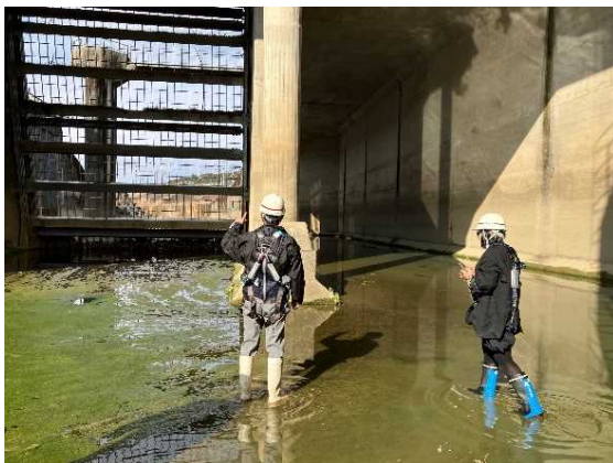
既設放水路の視察
