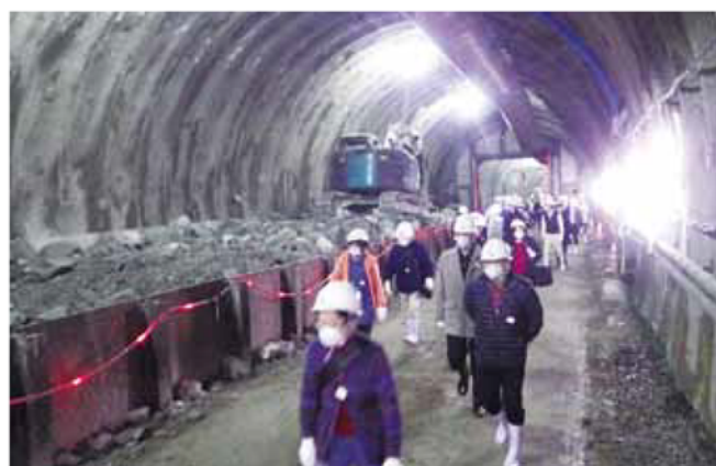
機械による素掘りの状態
