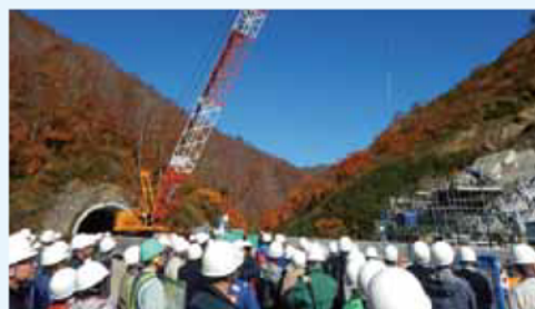
休日に実施される工事の見学会
