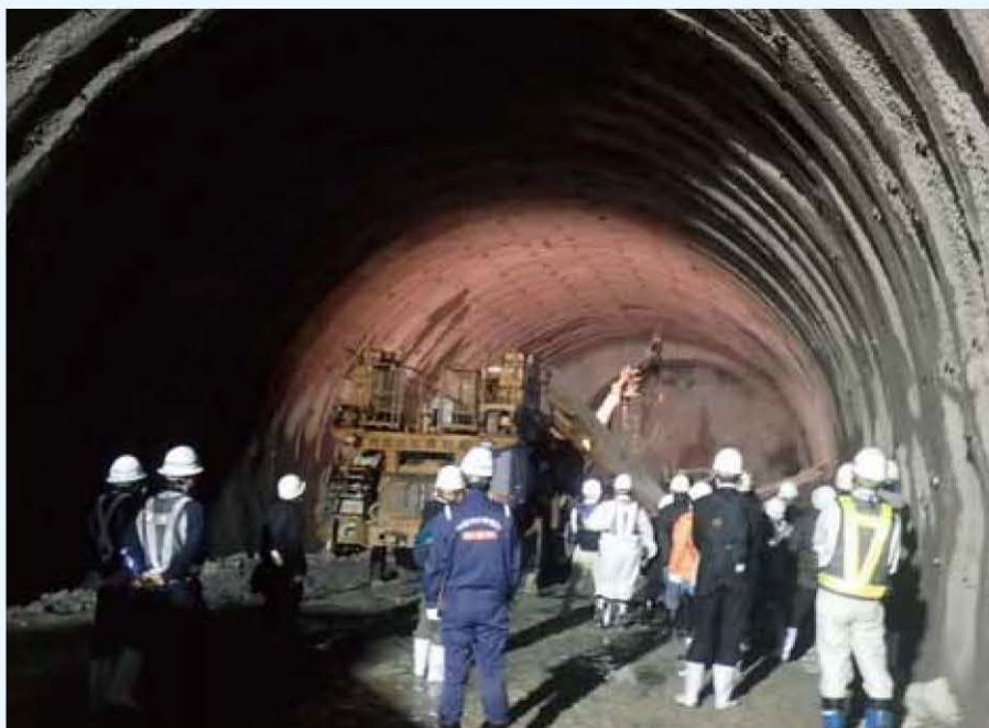
工事中の休山トンネルの見学
