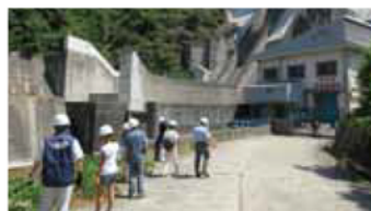
秘境八十里越体感バスのうち、複数のインフラを見る便（笠掘ダム）
