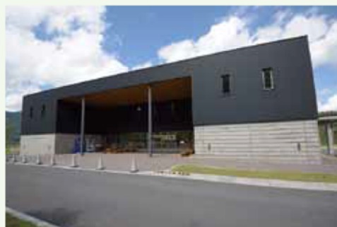
トイレがあるダム管理棟
