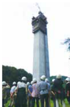
工事中の橋梁の見学
