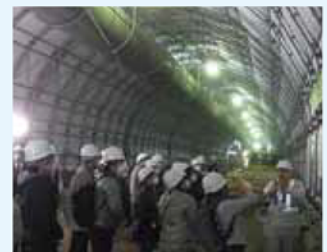
休山トンネル工事の見学
