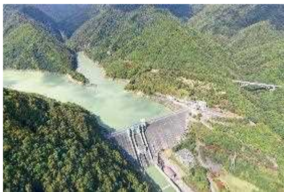
ガイド付き見学 (長野県 大町ダム)
