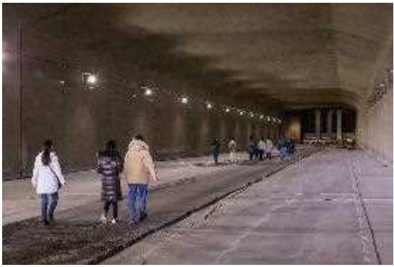
海底トンネルに潜入！東京湾アクアライン裏側探検 (東京都/千葉県 東京湾アクアライン・海ほたる)
