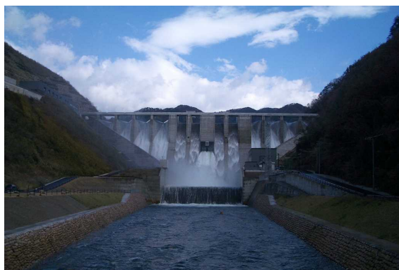
「ラビリンスなダム」苦田ダム見学 (岡山県 苦田ダム)
