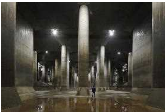
様々な特別見学ツアー (埼玉県 首都圏外郭放水路)
