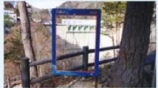
ダムの全景が見える視点場
