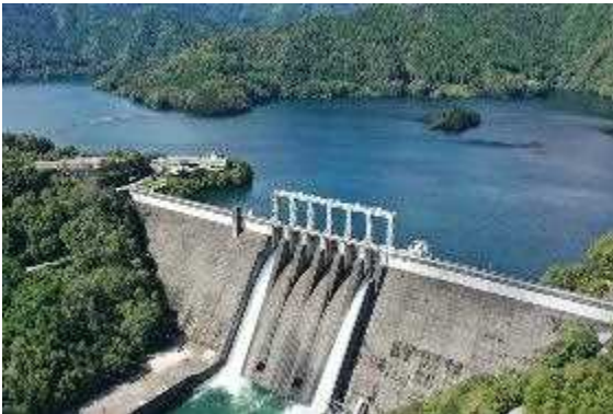
早明浦ダム役割や仕組みを見学 (高知県 早明浦ダム)
