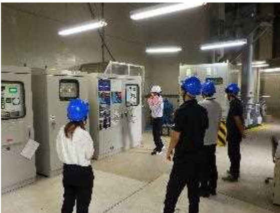
操作室やダム内部のゲート室の見学 (大分県 下釜ダム)
