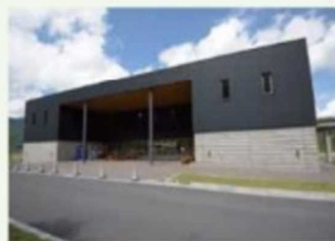
トイレがあるダム管理棟
