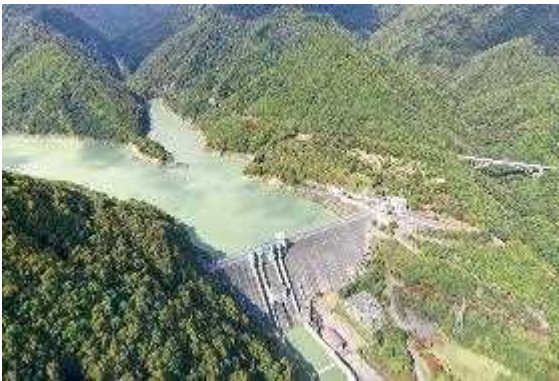
ガイド付き見学 (長野県 大町ダム)
