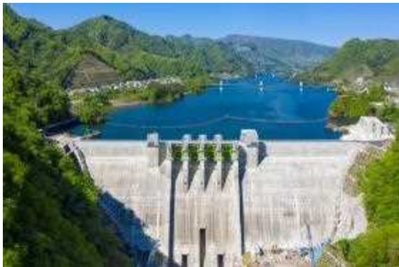
道の駅スタッフがご案内「ハッ場ダムツアー」 (群馬県 ハッ場ダム)
