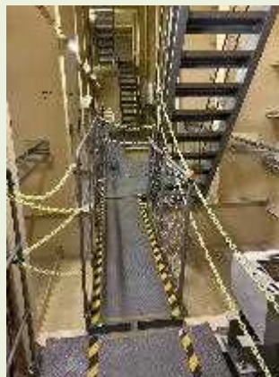
立ち入り禁止が分かるようロープを取り付け（画像左） 危険個所にテープを貼り付け（画像右）
