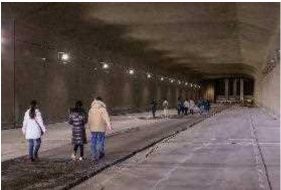
海底トンネルに潜入！東京湾アクアライン裏側探検 (東京都/千葉県 東京湾アクアライン・海ほたる)
