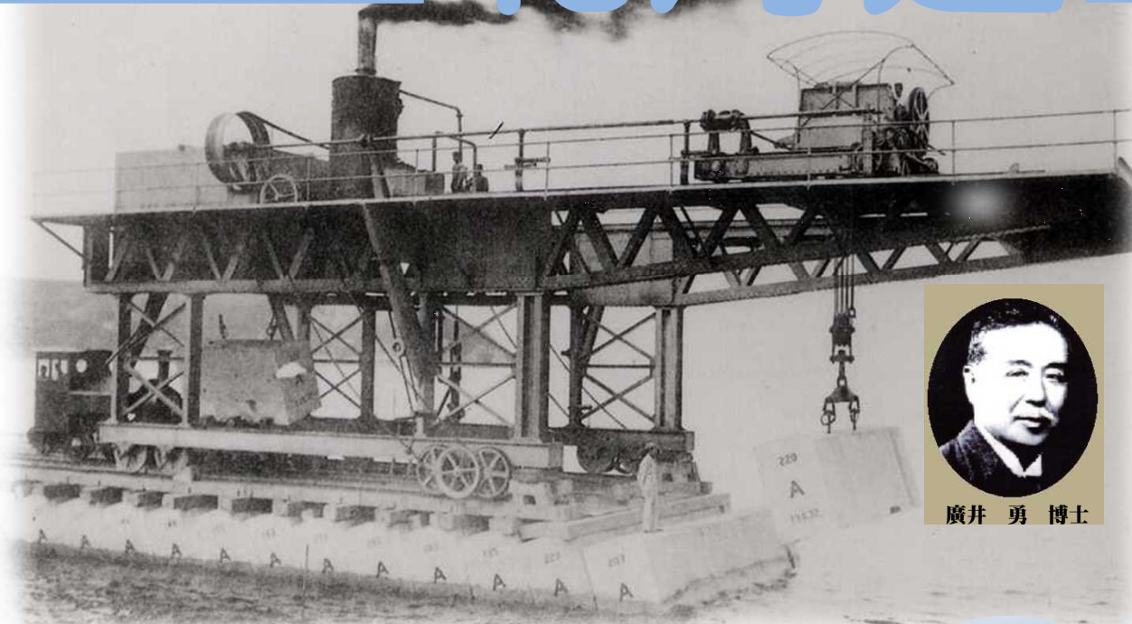
せきじょうき 防波堤上を軌道で移動し斜塊ブロックを設置する英国製積置機(タイタン)
