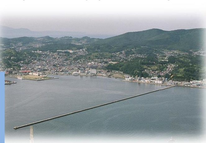
北防波堤 全景
