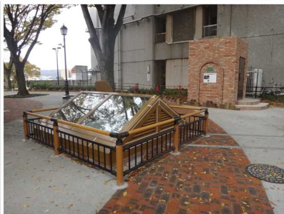
▲地上部の天窓から下水道管を見ることができます。
