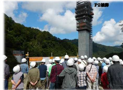
工事概要説明の状況(5号橋梁(P2橋脚)付近)
