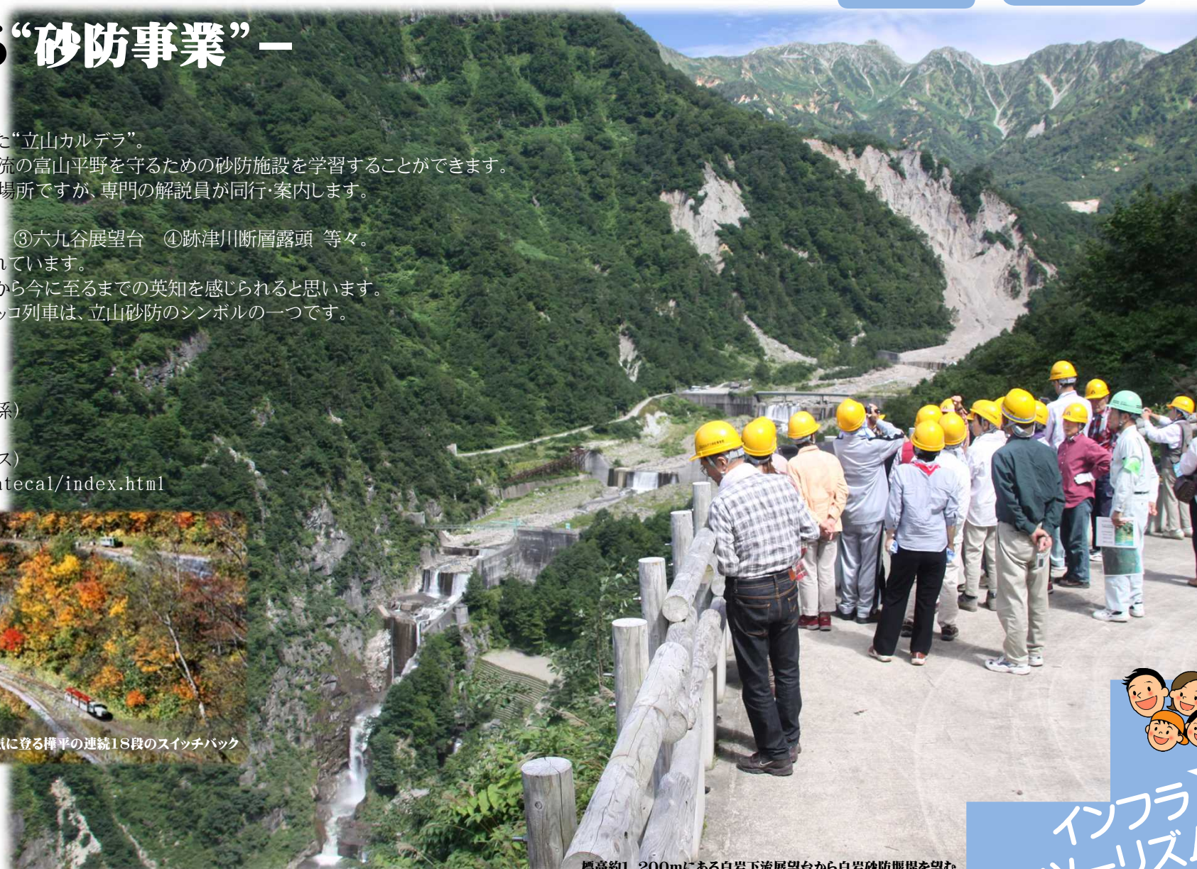
標高約1,200mにある白岩下流展望台から白岩砂防堰堤を望む
