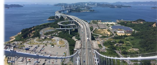
JR瀬戸大橋線が真横を駆け抜ける管理路
