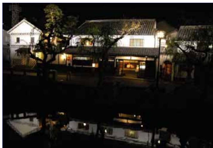
夜間景観照明
