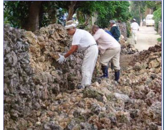
島民による石垣の修復
