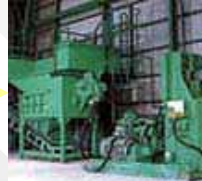
破砕施設(中間処理)
