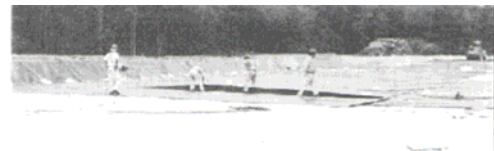
写真 遮水シートの敷設 1)
