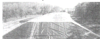
写真 遮水シートの敷設 1)
