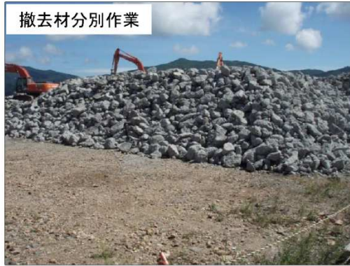
撤去材再生材生成状況
