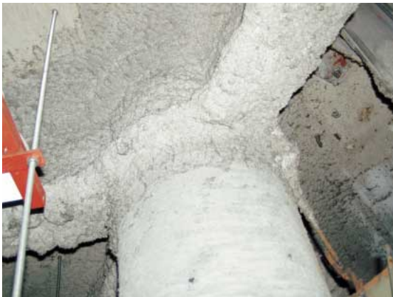
鉄骨耐火被覆
