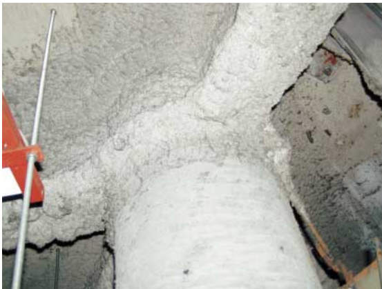
鉄骨耐火被覆
