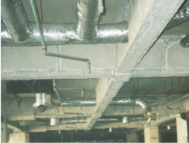
鉄骨耐火被覆
