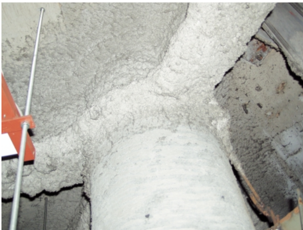
鉄骨耐火被覆
