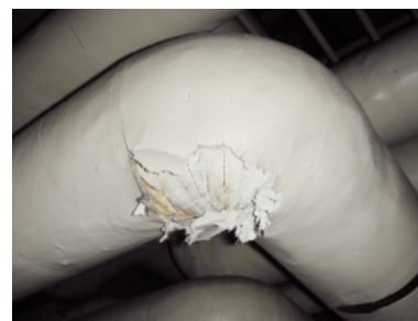
配管エルボの保温材
