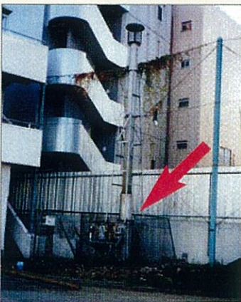
廃棄物焼却炉
