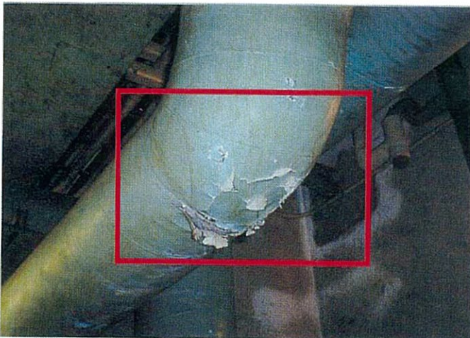
石綿含有保温材 (配管曲がり部)
