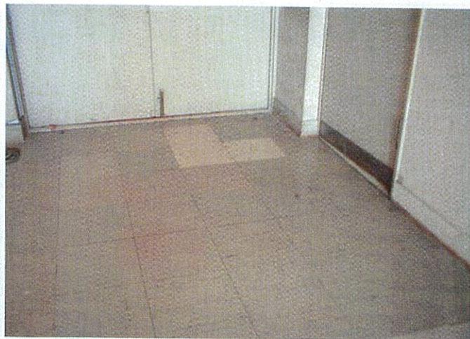
ビニール床タイル (石綿含有)
