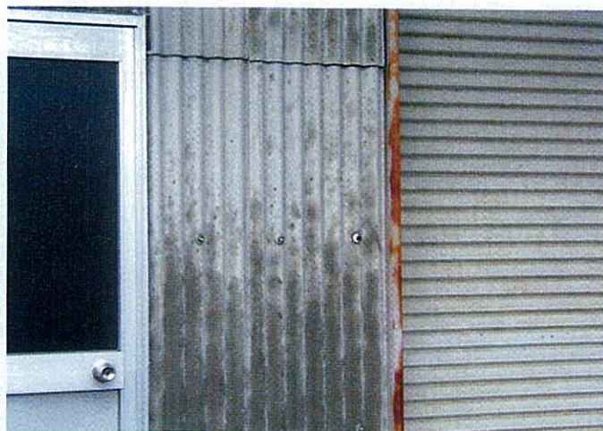
石綿スレート (波形)
