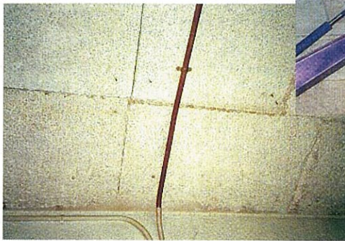
木毛セメント板打ち込み
