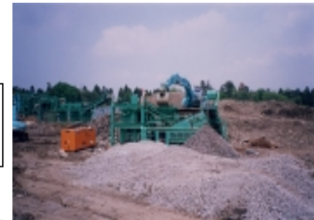
コンクリート塊破碎状況
