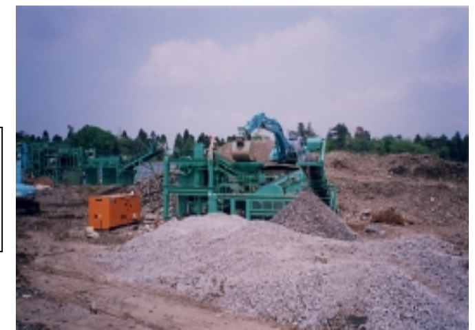
コンクリート塊破碎状況
