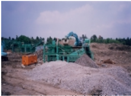
コンクリート塊破碎状況
