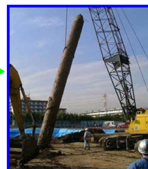
基礎及び基礎杭の撤去 2-21 -
