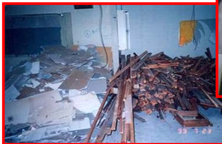
内装材(木材・廃石膏ボード)の分別
