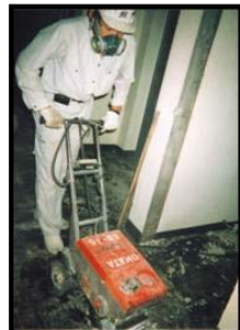
アスベスト含有形成版撤去
