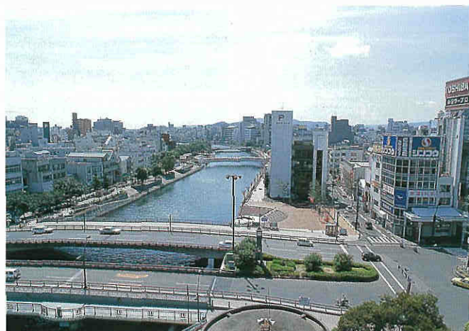
新町橋際には親水護岸と浮き桟橋による水上ステージが設けられている
