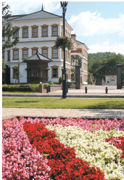
▲移築復原された旧小坂鉱山事務所
