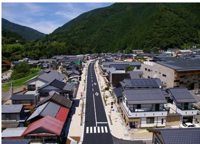
「国道440号まち中工区」の全景
