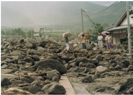
度重なる土石流の被害にあった安中三角地帯
