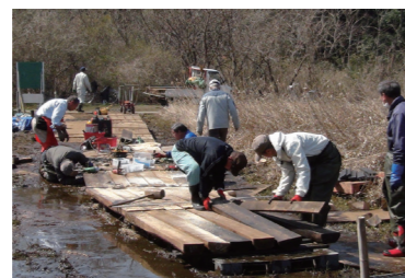
湿地環境での基礎設置 天板取付作業
