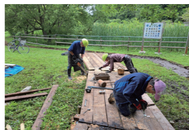
林間コース 土の道の木道化作業
