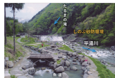
しのぶ砂防堰堤
