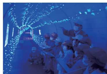
しのぶ砂防堰堤監査廊 イルミネーション
