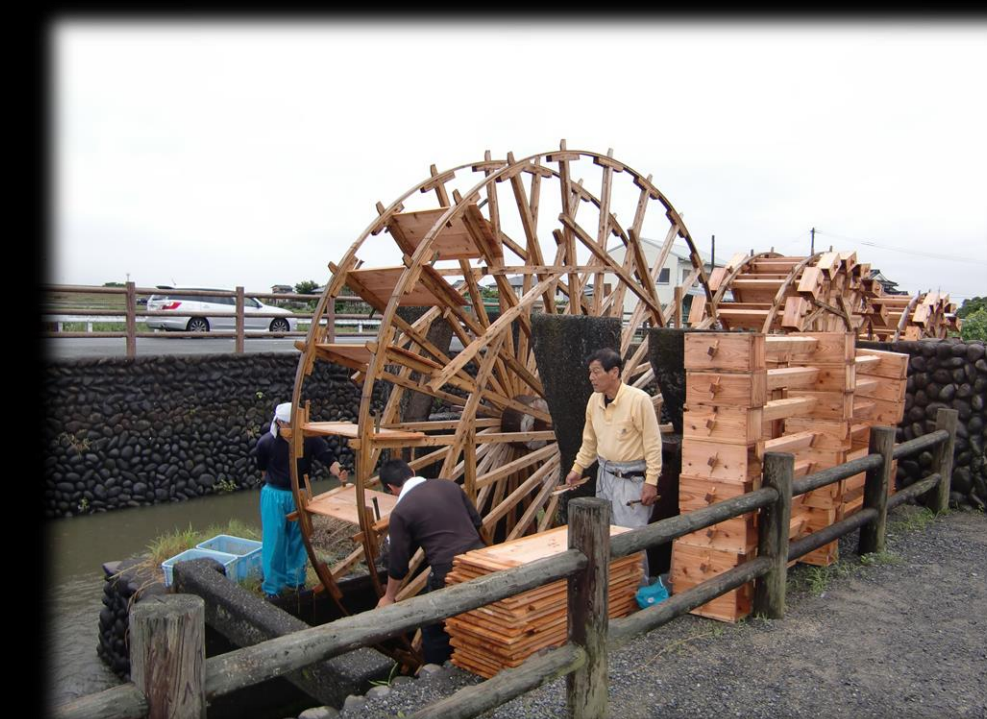
水車の更新作業
