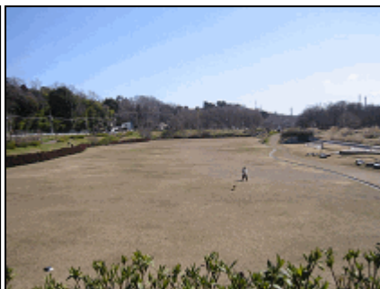
野川第二調節池
