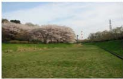
野川第一調節池
