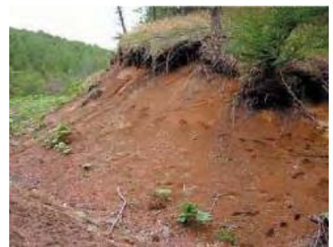
土砂流出が懸念される箇所
