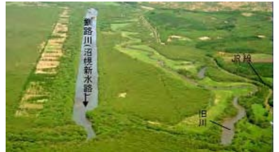
直線化した河道
