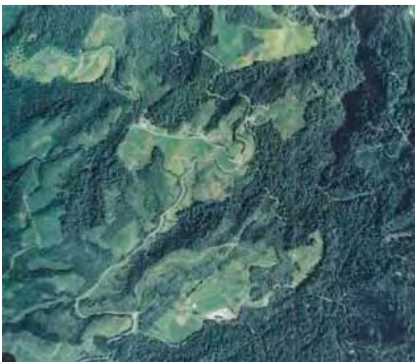
昭和50年頃からおよそ500haもの広大なブナ林が伐採され、牧場造成工事が実施された
