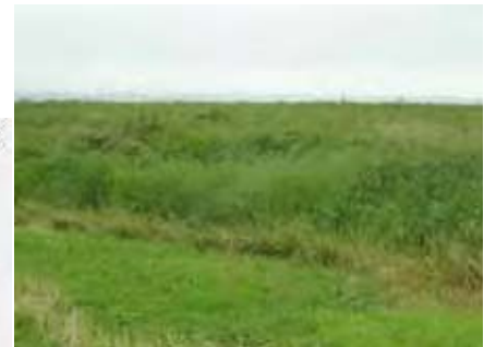
農地の地盤沈下 手前の牧草が奥の湿原より 1mほど低くなっている
