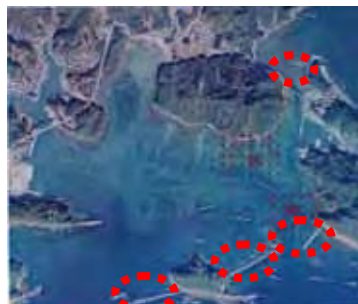
防波堤整備箇所(赤点線部分)
