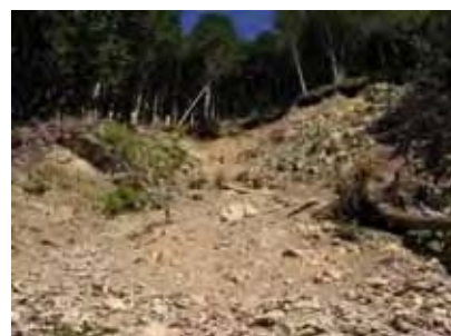
植生の回復が見られない崩壊地 （西の川流域）
