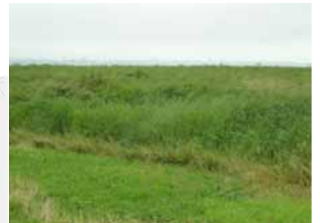
農地の地盤沈下 手前の牧草地が奥の湿原より 1mほど低くなっている
