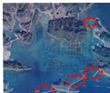
防波堤整備箇所(赤点線部分)
