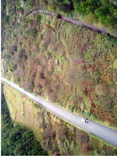
排水施設や道路建設が原因と思われる 湿原の乾燥化が進行している
