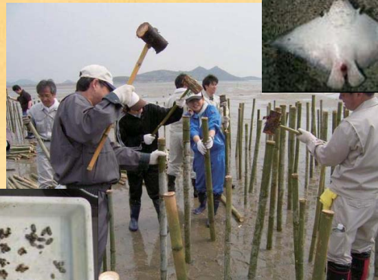
竹柵の設置状況
