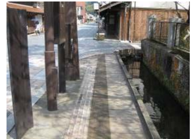
蓋のない水路、支柱による狭さく部
