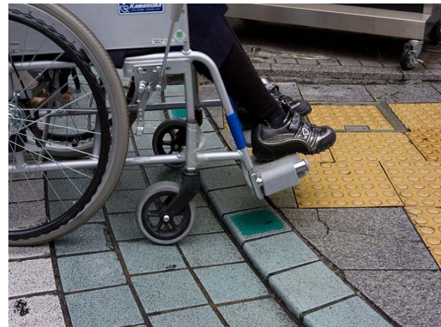
歩道上の段差
