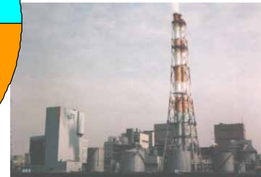
川崎火力発電所 65.5万kW
