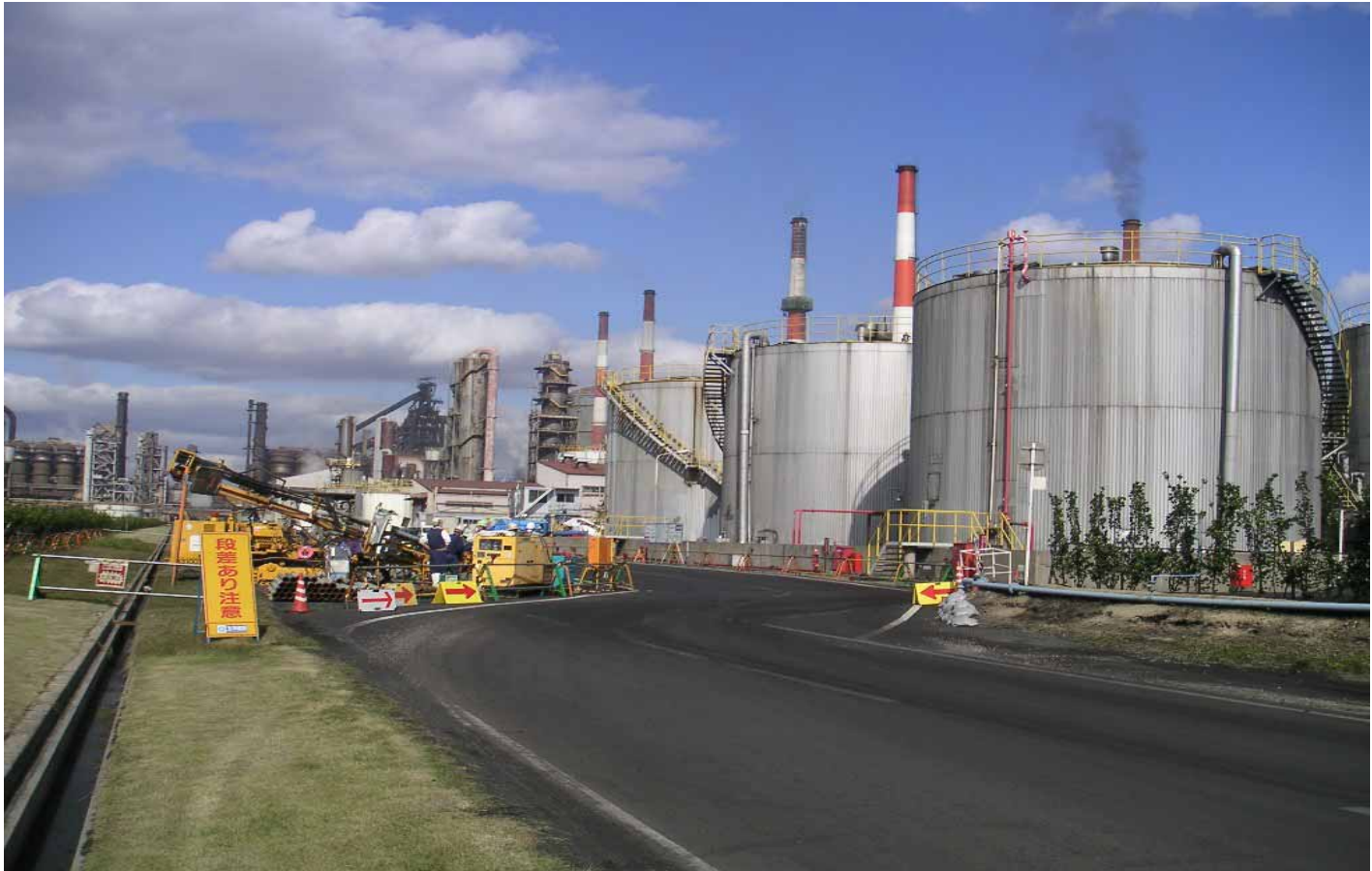
中国地区の旧法タンク基礎の液状化対策施工状況
