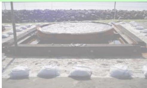
泥干潟実験タンクの設置:造成干潟の上に泥(浚渫土)を充填したミニ干潟を設置し、異なる地盤高での生物定着や地形変化を観察しています。(五洋建設)
