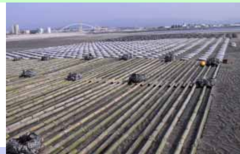
干潟に様々な構造物を設置することで、地形を安定化させる工法の開発を行っています。(鹿島建設・大成建設)
