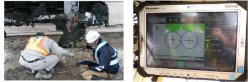
(従来)誘導員による位置決め (ICT)施工位置のガイダンス画面(例)
