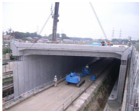
写真-プレキャスト部材架設状況
