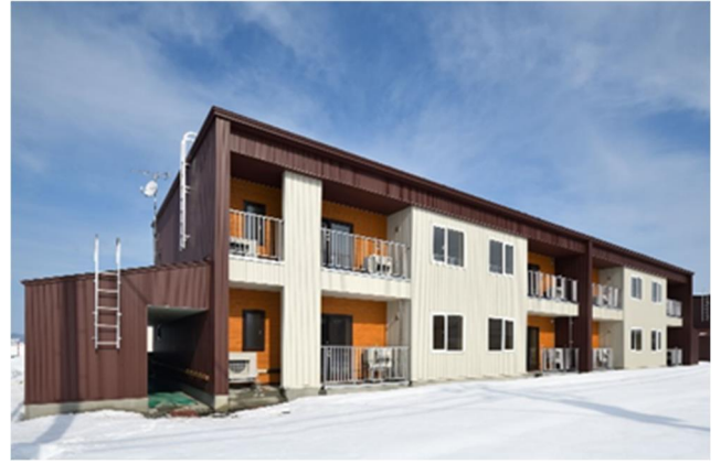
【住宅事業】低層公営住宅 (北海道栗山町)
