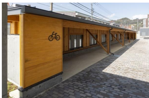
福島第2地方合同庁舎 自転車置場 (福島県福島市)
