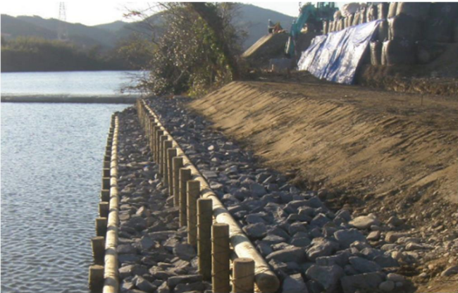
【河川事業】護岸工 (宮崎県延岡市)
