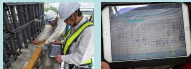
現地立会 出来形確認(ASP直接入力)
