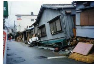
木造住宅の大地震における被害
