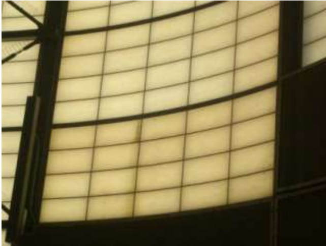
写真 5-8 採光部の汚れ
