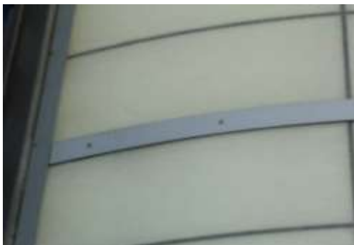
写真 5-6 金属平板と皿ビスによる固定①
