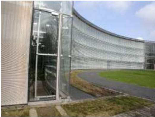
写真 3-8 ダブルスキン部分の外観
