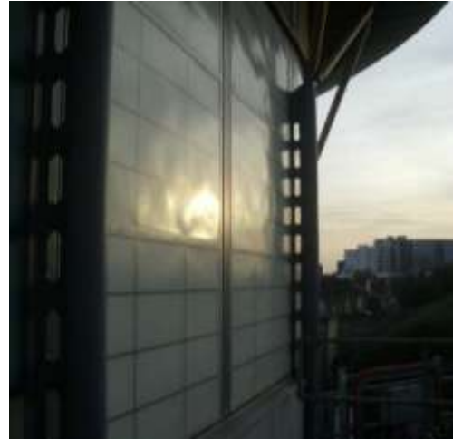
写真 5-9 外装の変形
