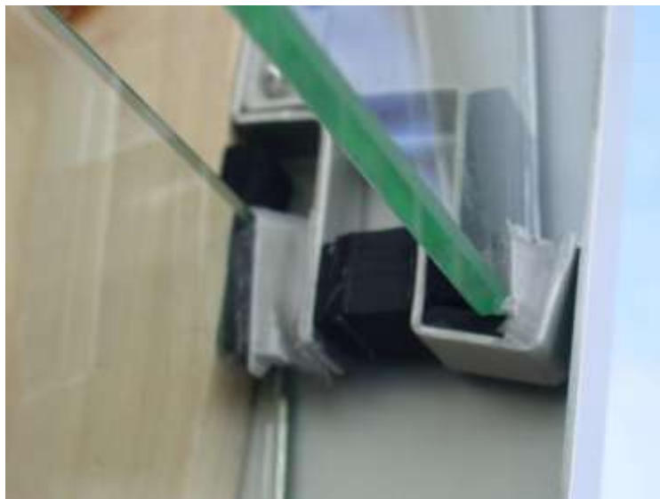
写真2-8 ガラス支持金具の強度不足による垂れ下がり
