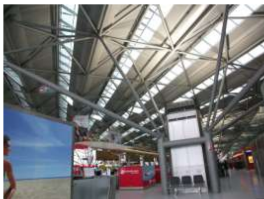
写真 3-17 屋根を支えるトラス構造①
