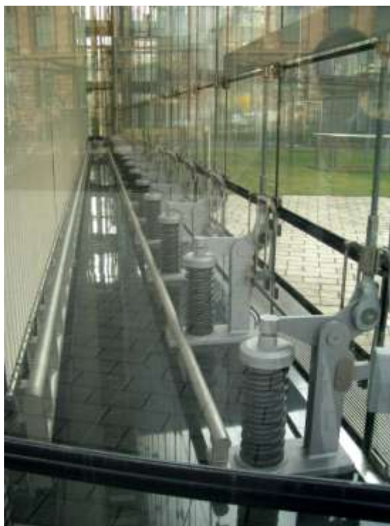
写真 3-14 ガラス支持部材（ワイヤー）のばねを用いた引張機構
