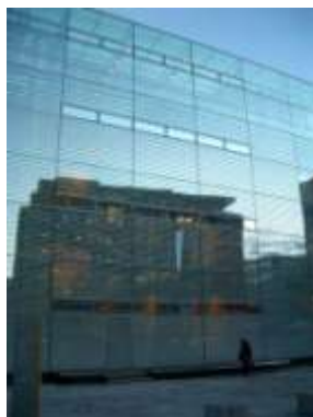
写真 3-2 ガラスファサード
