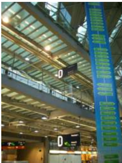
写真 3-24 中間階の透光性を有する床材
