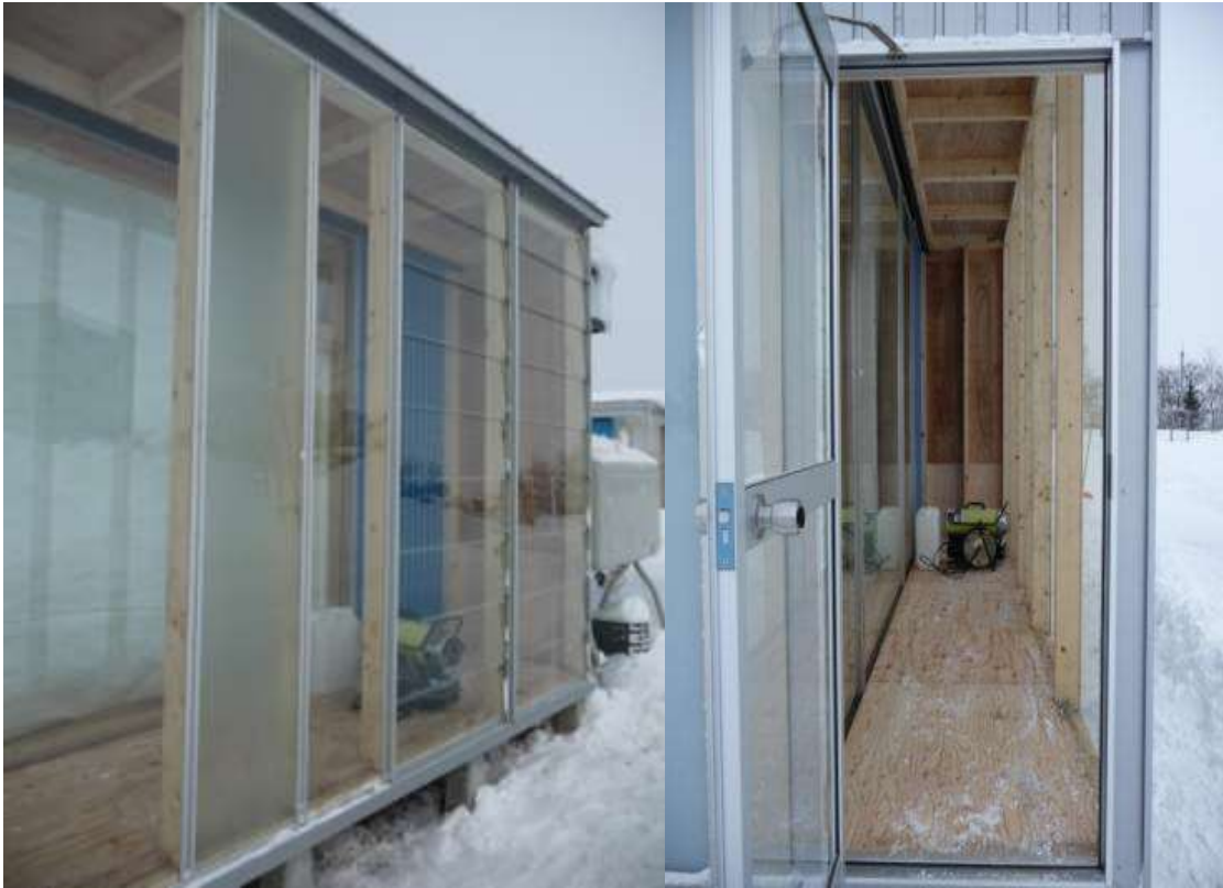
写真2-11 2010年に完成したモックアップ試験体（奥側が下見板張り状）
