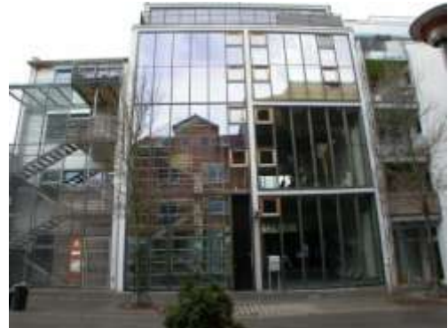
写真 2-7 ガラスファサードの事務所併用集合住宅
