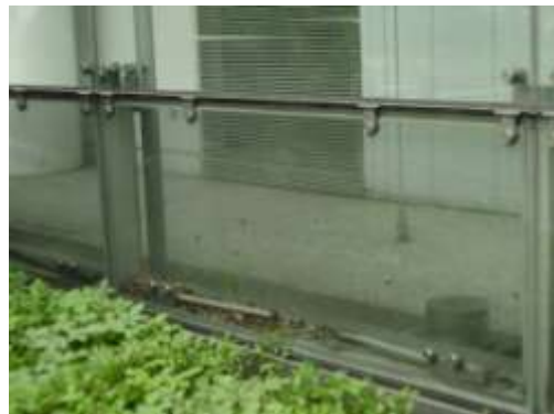
写真2-16 ダブルスキンファサード有する建築物
