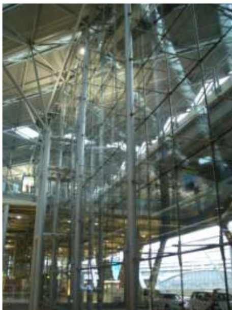
写真 3-21 ガラスファサードに用いられる金属部材 1
