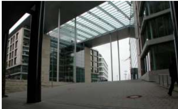
写真 1-6 LBBW 事務所棟の透明天蓋
