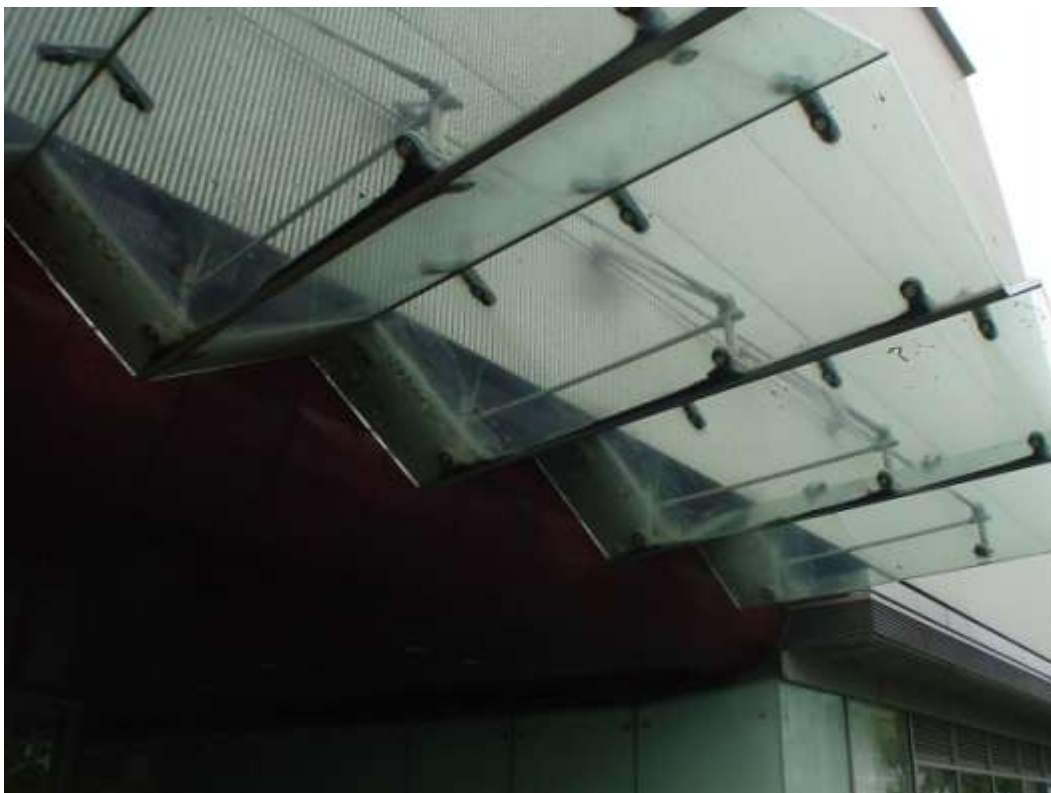
写真2-18 雨がかりとなりやすく、鳥が留まりやすい場所で発生する顕著な汚れ
