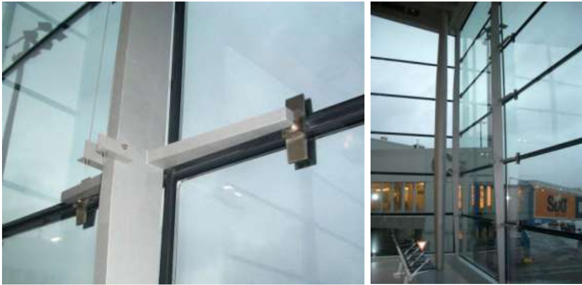
写真 3-22 ガラスファサードに用いられる金属部材 2
