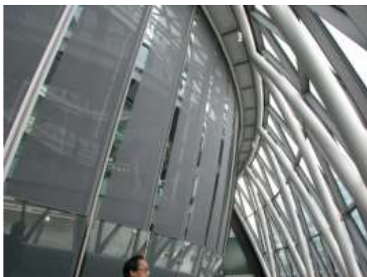
写真 4-5 建物内観 3（ホール上部）
