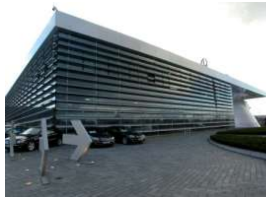
写真 3-28 曲面天井により自然光照明を実現 写真 3-29 多段階ルーバを用いたガラスファサード
