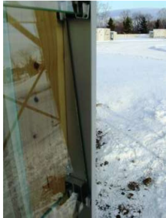
写真2-7 下見板張り側面の収まり
