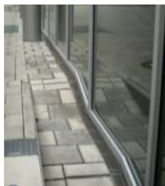
写真 1-4 ガラスファサード下部のディテール
