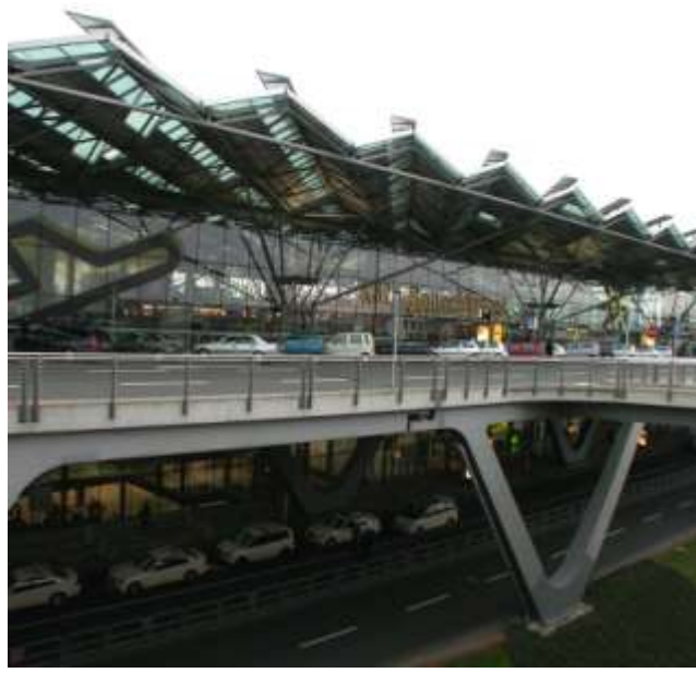
写真 3-19 建物外観と屋根形状
