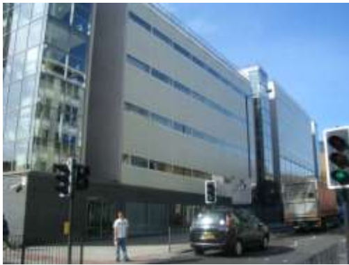
写真 5-1 KALWALL を用いたファサード
