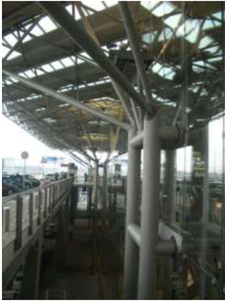
写真 3-18 屋根を支えるトラス構造②
