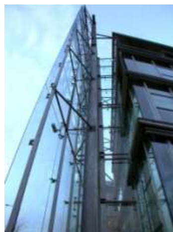
写真 3-27 ガラスファサードの支持方法
