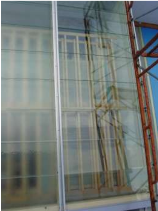
写真2-6 下見板張りのガラスファサード
