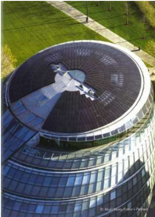
写真 4-6 屋上の太陽電池パネル (パンフレットより)
