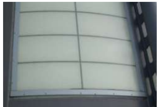
写真 5-7 金属平板と皿ビスによる固定②
