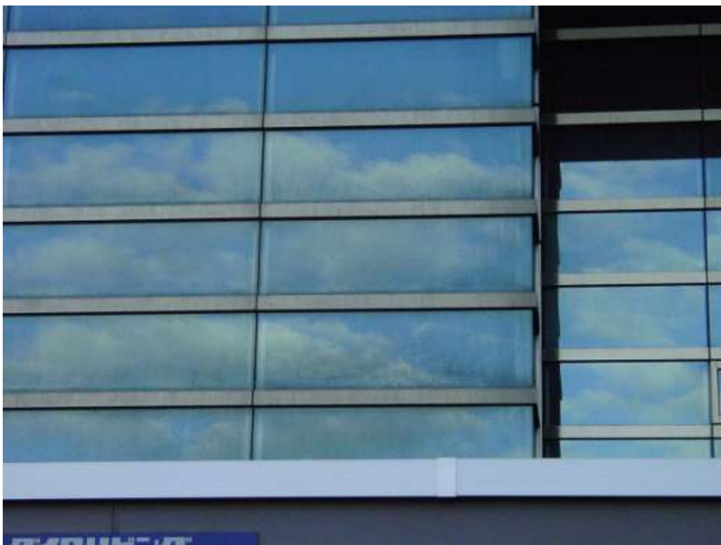
写真 2-17 サッシュ枠の周辺部に汚れが蓄積しやすい傾向を示す例
