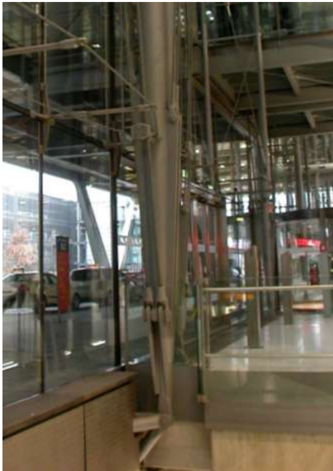
写真 3-21 ガラスファサードに用いられる金属部材 1
