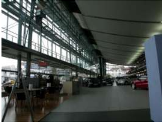
写真 3-28 曲面天井により自然光照明を実現 写真 3-29 多段階ルーバを用いたガラスファサード
