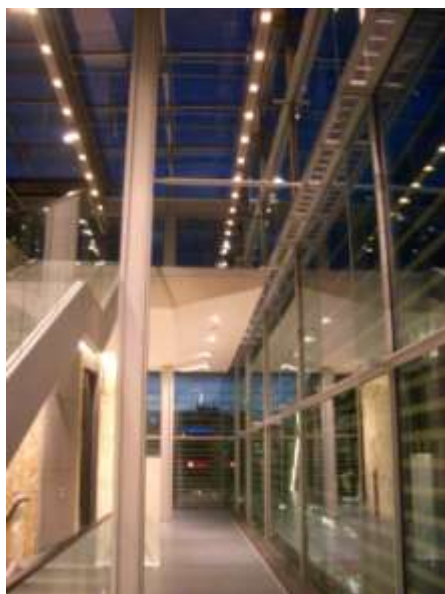
写真 3-4 ガラスファサードの支持方法 1
