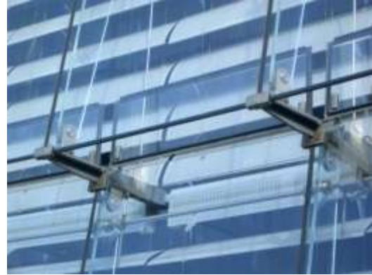
写真 3-9 ダブルスキン内部の小型通風口
