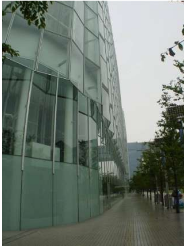
写真2-19 視線制御と路面に滴下した雨粒の跳ね返りによる汚損を防止する フィルム付ガラス
