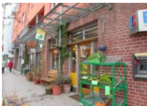
写真 2-1 1階が商業施設の集合住宅（改修）
