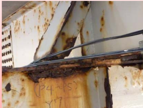
付着塩分による鋼橋の深刻な腐食
