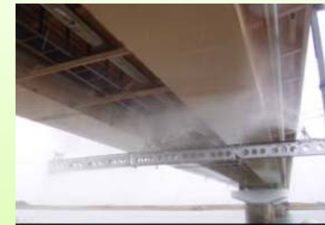
橋梁洗浄機の開発 橋梁洗浄の実施
