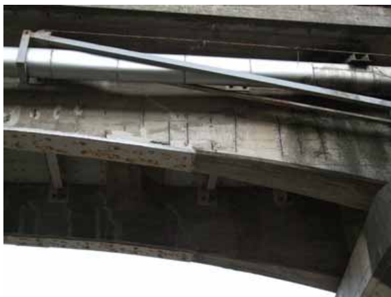
写真4-2 かぶり不足による鋼材露出
