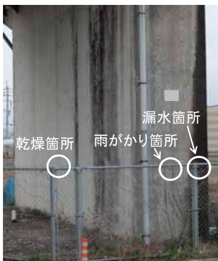
図 19 測定箇所(C橋:橋脚)
