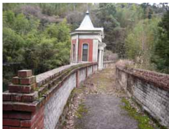
写真7-2 堰堤上面路面
