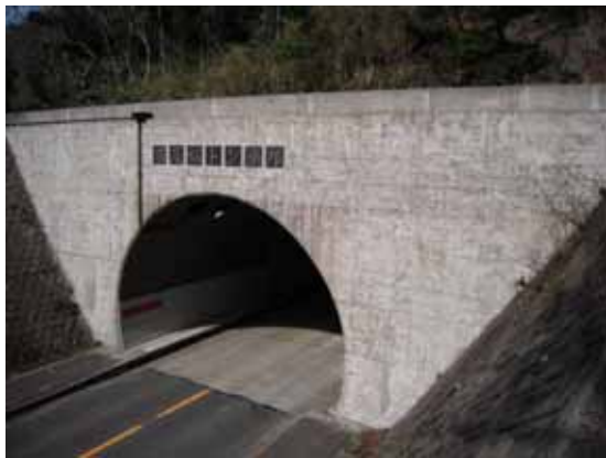
写真1-1 トンネル坑口（出口側）
