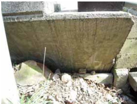
写真1-3 トンネル側面
