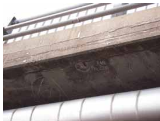
写真3-4 床版下面の鋼材露出
