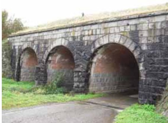
写真14-1 内田川橋梁（東側）
