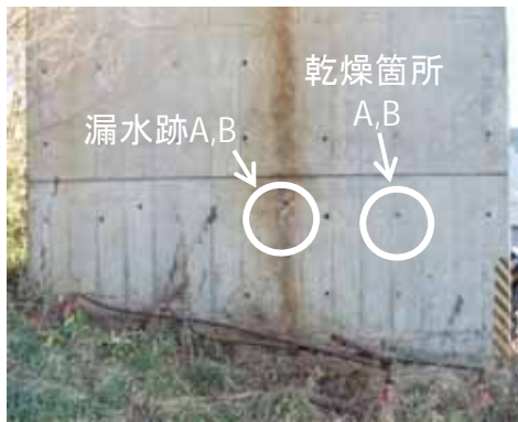
図 17 測定箇所(M橋:橋脚)
