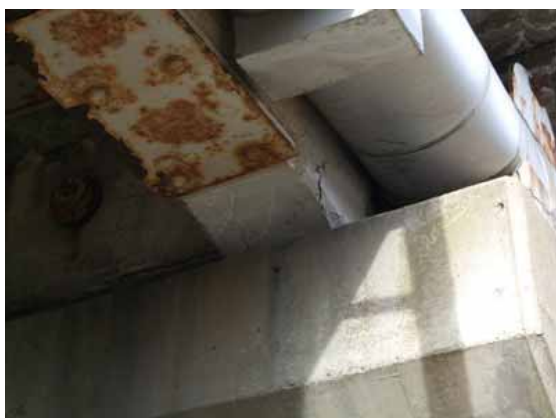
写真3-3 梁端部の浮きとひび割れ
