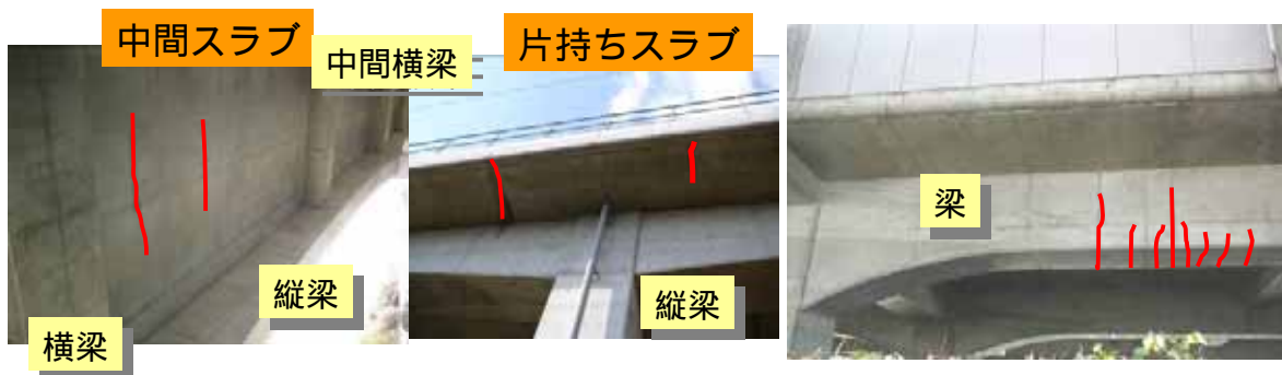
写真-1 RCラーメン高架橋でのひび割れ発生例
