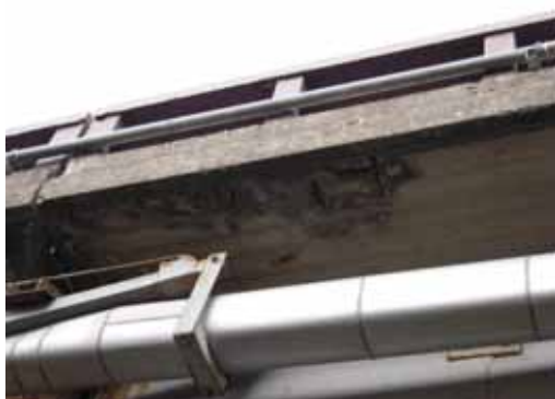
写真4-3 床版下面の鋼材露出
