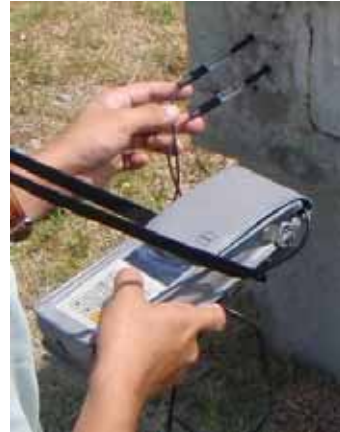
図2 コンクリート内部含水率の測定
