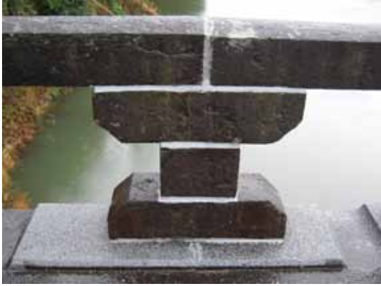
写真12-2 欄干補修状況
