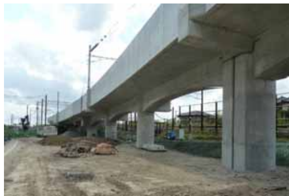
図-2 高架橋の周辺状況
