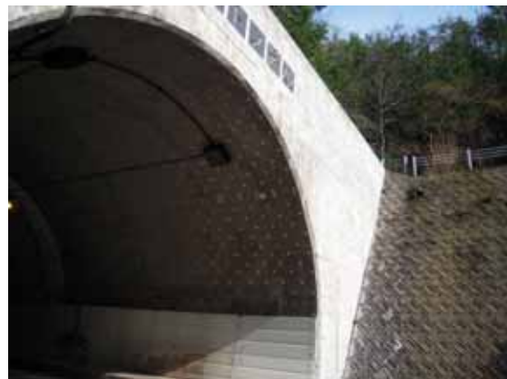
写真1-4 剥落防止工
