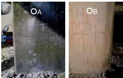
図 15 測定箇所(O 橋:橋脚)
