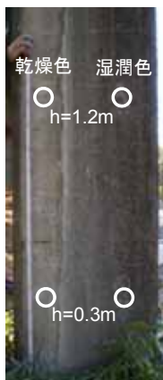
図 13 測定箇所 (K 高架橋:柱)
