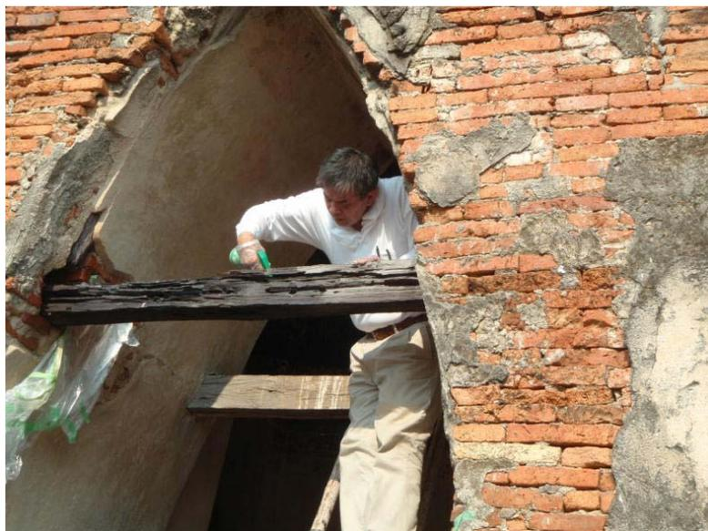
Fig. 38 含浸強化剤吹き付け (1回目)
