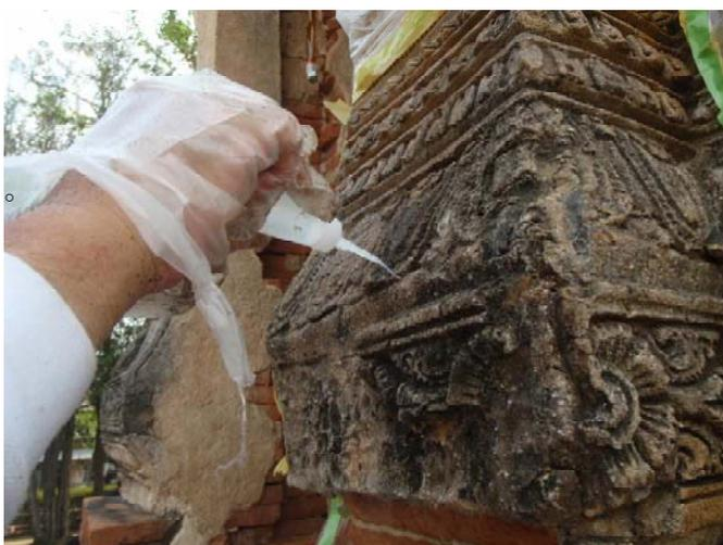
Fig. 19 仕上げレリーフ部分とベースになる漆喰層の接着
