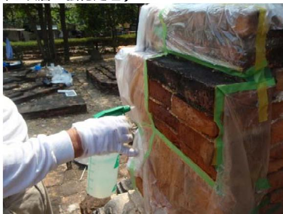
Fig. 21 強化剤吹き付け（1日目の1回目）
