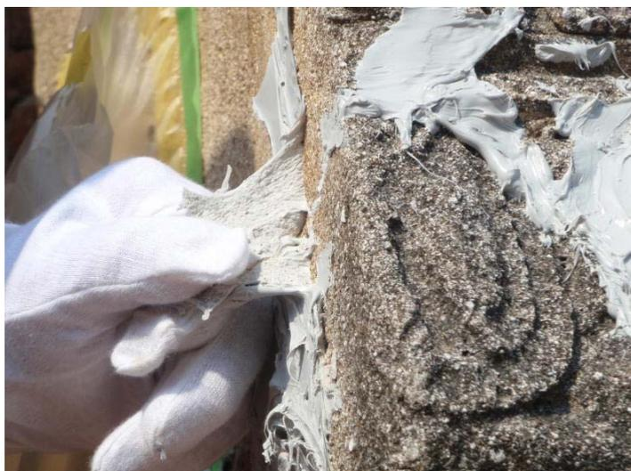
Fig. 15 シーリング除去(接着剤硬化後確認後)
