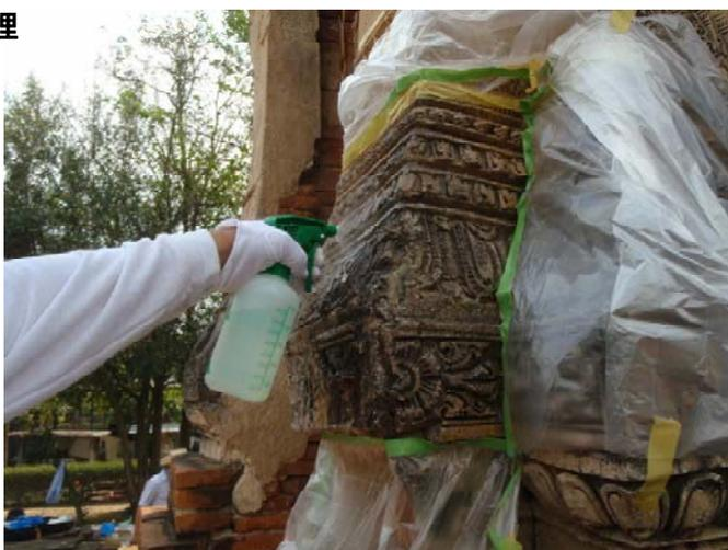
Fig. 18 含浸強化剤吹き付け (1回目)
