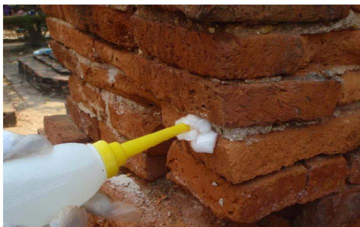
Fig. 26 水の上昇抑制処理注入状況
