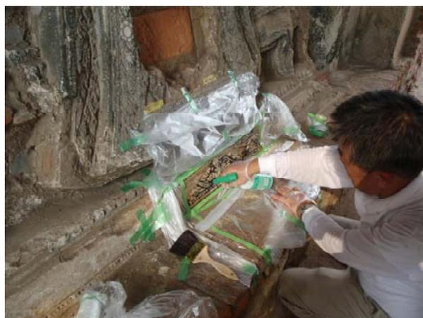
Fig. 32 含浸強化剤吹き付け (1回目)
