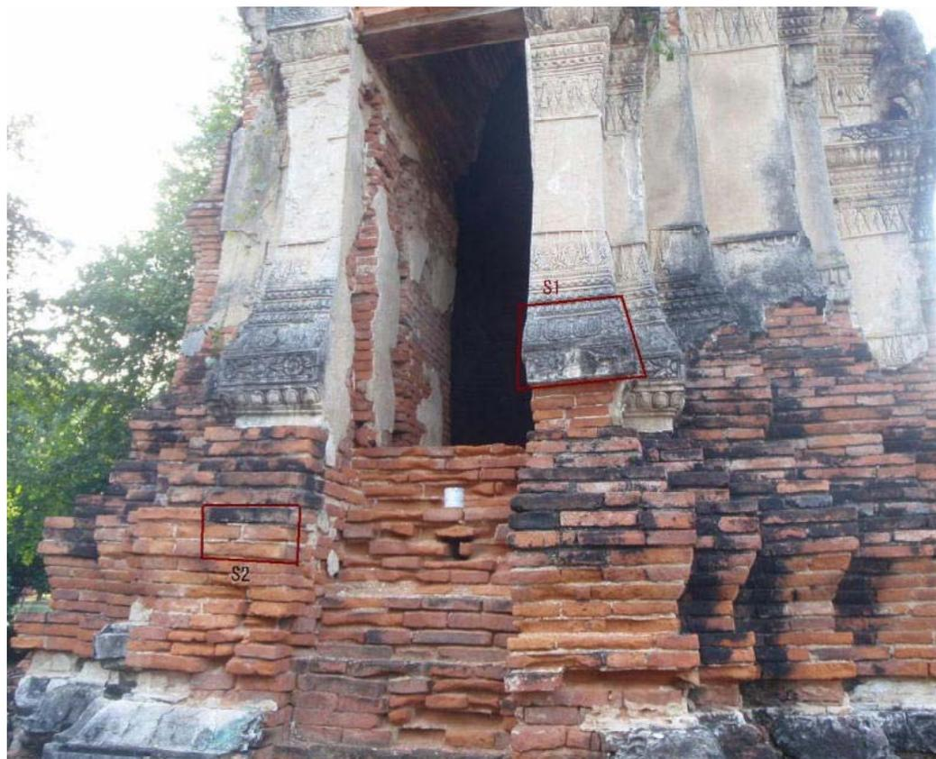
Fig. 5 処理前強度試験および強化処理の位置
