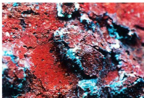
(a) 煉瓦の塩類結晶膨張による部分的隆起
