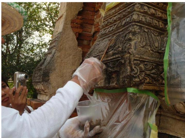
Fig. 17 欠損箇所復旧
