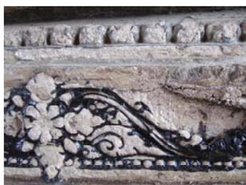
Fig. 34 含浸強化剤吹き付け終了部分拡大
