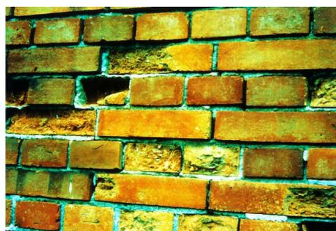
(b) 塩類風化による煉瓦の欠損
