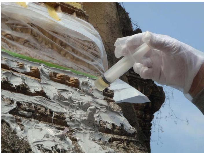
Fig. 14 接着剤手動低圧注入
