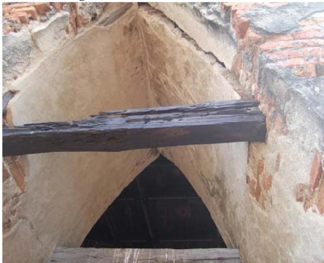
Fig. 61 木製タイバー施工直後
