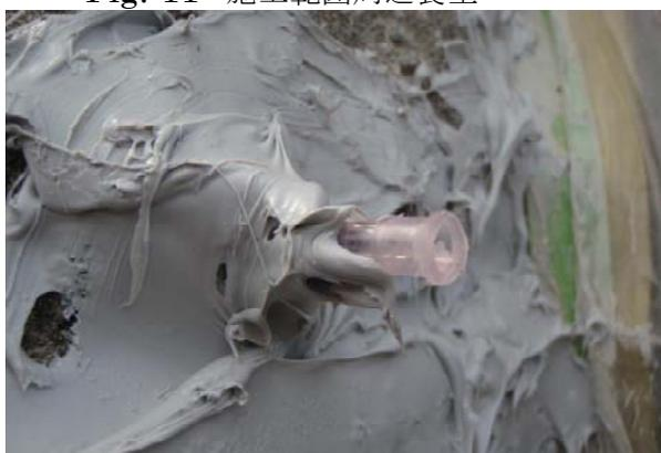
Fig. 12 接着剤注入治具取り付け
