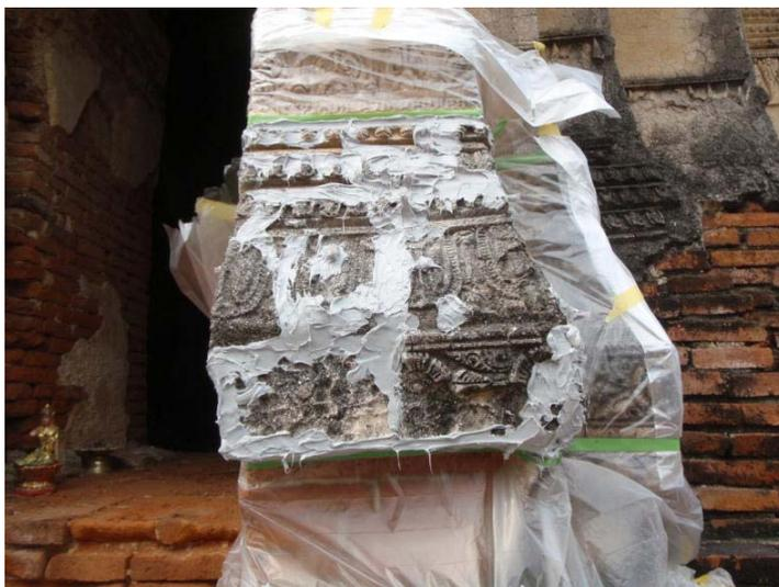
Fig. 13 ひび割れシーリング
