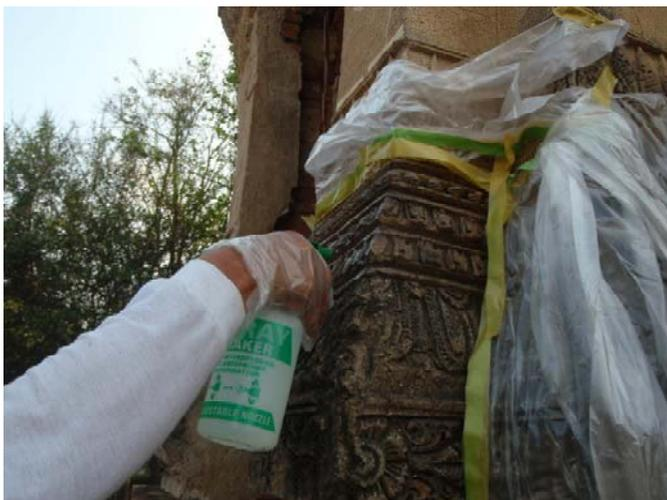
Fig. 20 含浸強化剤吹き付け（2回目）
