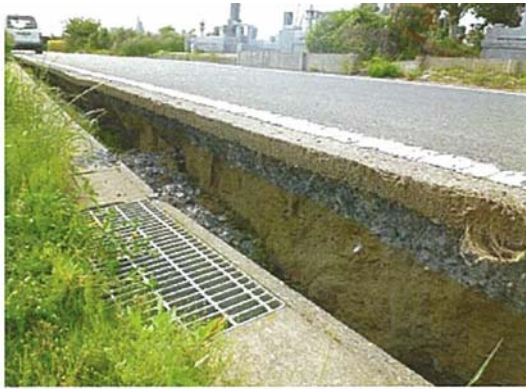
写真 3. 2. 129 道路側溝の沈下
