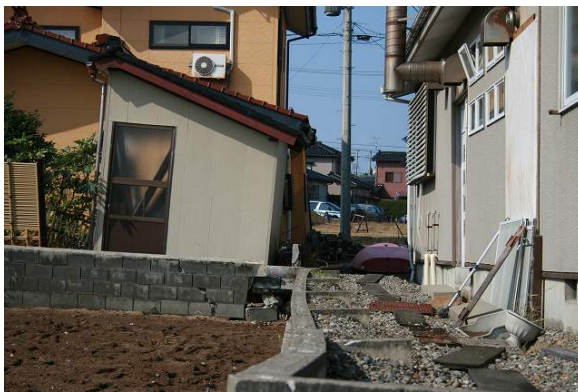
写真 3. 2. 72 建屋 a（写真右）の南側土留め壁の変位、正面は家屋 24
