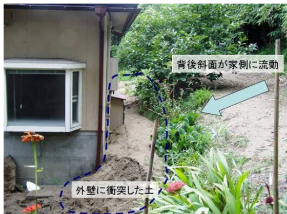
写真 3.2.12 砂丘斜面の流動による 家屋被害 1
