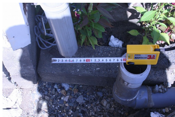
写真 3. 2. 75 建屋 c の建物と地面のギャップ
