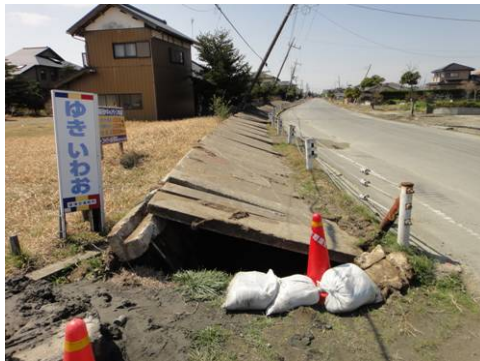
写真 3. 2. 126 道路側溝の隆起現象
