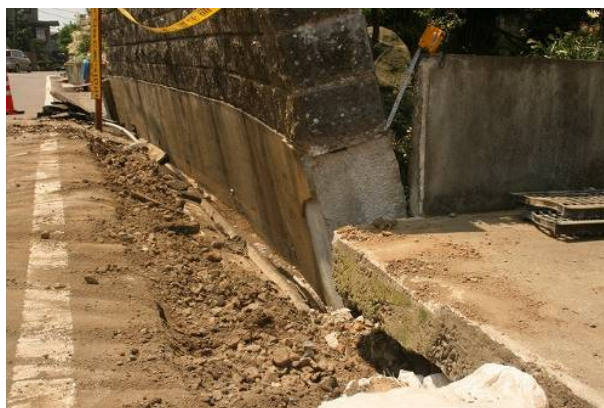
写真 3.2.114 玉突き状に押された下段 (o 宅)
