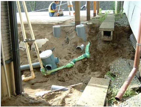
写真3.2.101 宅地内に生じた段差 (図3.2.84のPhoto(A)) (写真3.2.100の家屋の別アングル)
