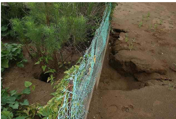
写真 3.2.65 敷地境界に跨る噴砂孔と、 懸垂しているブロック塀 (撮影地点⑫)
