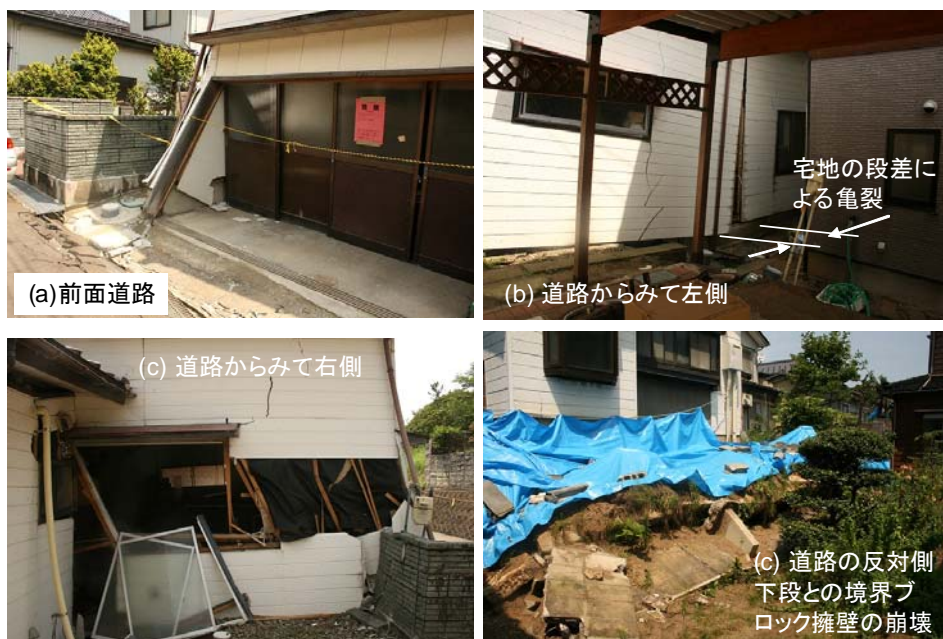
写真 3.2.105 家屋下を過った滑落崖被害 (c 宅)
