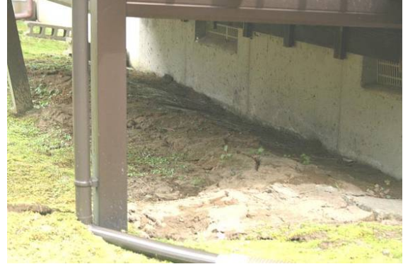
写真 3. 2. 41 建物背面の地盤の隆起 (No. X)
