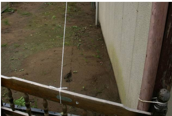
写真 3.2.32 宅地内の噴砂痕 (No. 16)
