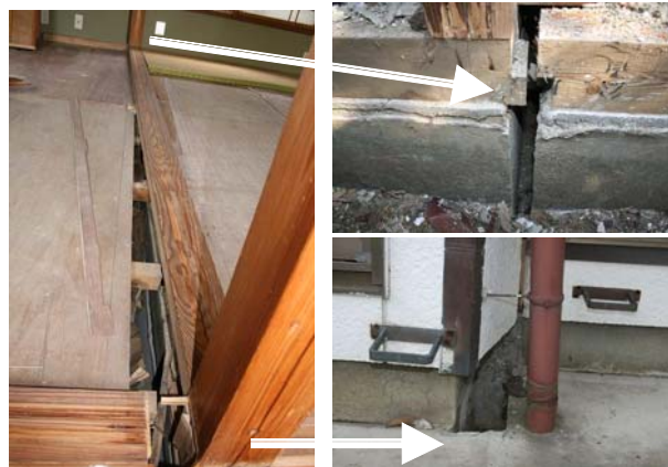
写真 3.2.112 床の開きと基礎の離隔 (k 宅)
