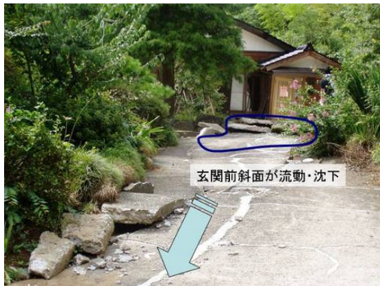
写真 3.2.9 宅地の沈下・流動による 家屋被害 1
