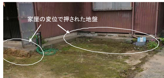
写真 3.2.37 家屋に押された前庭 (No. II)
