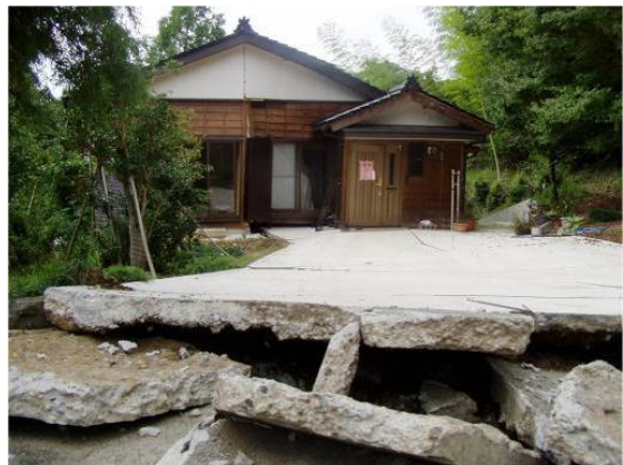
写真 3.2.10 宅地の沈下・流動による 家屋被害 2
