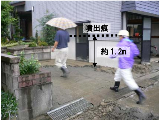
写真 3.2.43 宅地内の噴砂（旧河道上）
