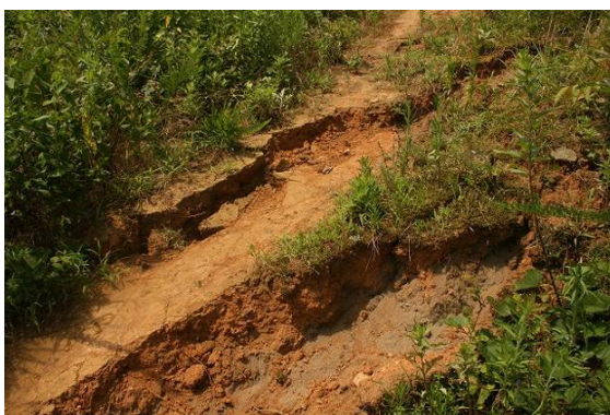
写真 3.2.108 h 宅と向かいの砂丘斜面の亀裂
