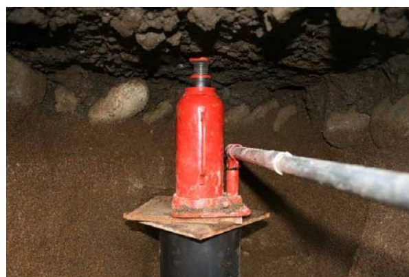
写真 3. 2. 74 パイルソケットによる 家屋 15 のジャッキアップ
