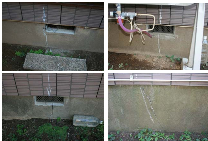
写真 3. 2. 81 通気孔のひび割れ（家屋 h）
