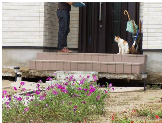
写真 3.2.11 宅地の沈下・流動による 家屋被害 3
