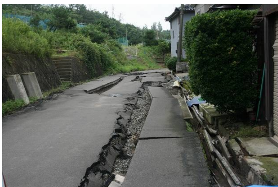
写真 3.2.107 g 宅と h 宅前の道路の亀裂写真
