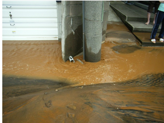
写真 3.2.68 本震 12 分後の噴砂・噴水 と電柱の沈下 (撮影地点⑮)
