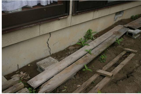
写真 3.2.31 基礎の亀裂 (No. 16)
