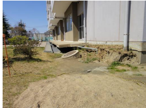
写真 3. 2. 124 建物の基礎地盤の沈下
