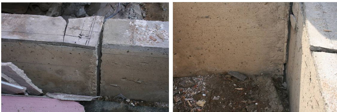
写真 3. 2. 76 打ち継ぎ目に鉄筋無し（家屋 e） 写真 3. 2. 77 基礎のコーナーにも鉄筋無し
