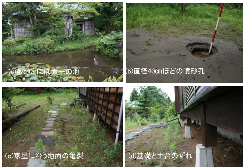
写真 3. 2. 21 低湿地の液状化関連被害 (No. 7)
