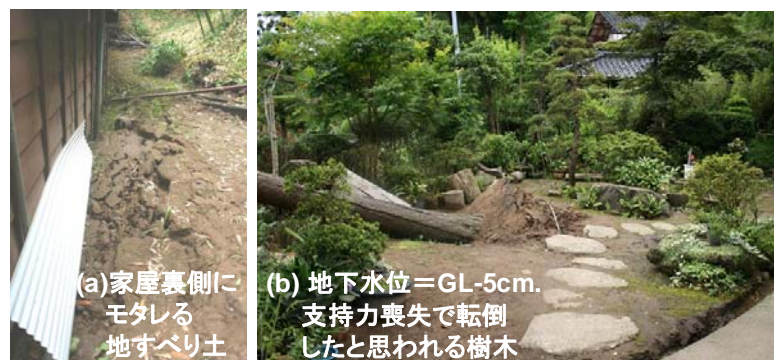
写真 3.2.19 土砂の直撃と浅層の液状化 (No. 4)
