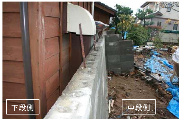
写真 3.2.106 土留めブロック擁壁の衝突
