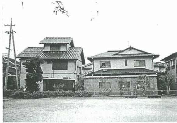
写真 3. 2. 120 鳥取県西部地震で不同沈下した住宅の例 34)
