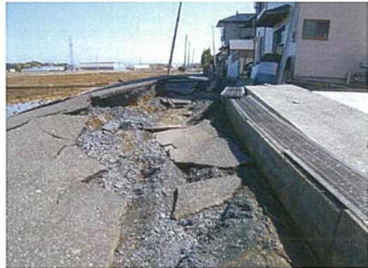
写真 3. 2. 129 道路側溝の沈下
