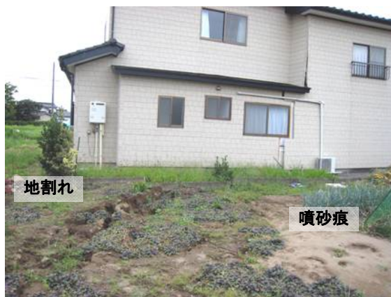
写真 3. 2. 49 住宅地内の地割れと噴砂痕
