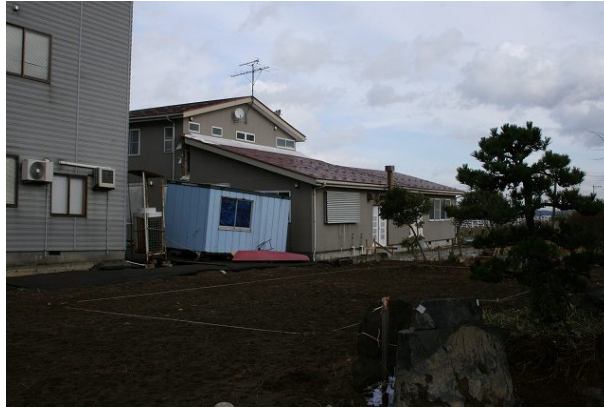
写真 3. 2. 71 家屋 a の北側二階建て部分と南側一階建て部分の裂損
