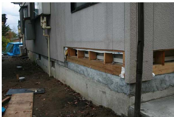
写真 3. 2. 33 噴砂痕は無いが不同沈下 (No. 17)
