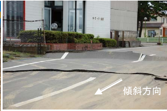
写真 3.2.62 地盤の傾斜方向への舗装の流れ (本震 4 時間後) (撮影地点⑨)
