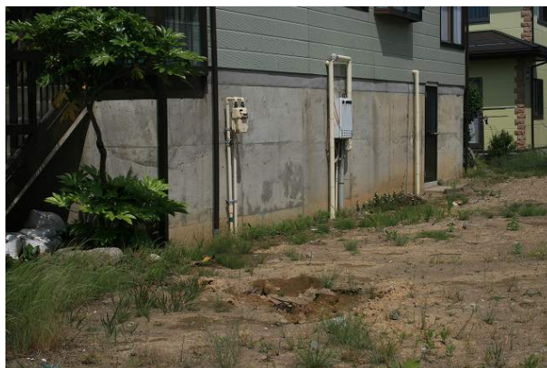
写真 3. 2. 80 全体沈下はあるものの、家屋の被害は軽微だった高床式基礎（家屋 h）
