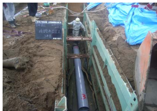
写真 3.2.117 暗渠排水管の布設状況
