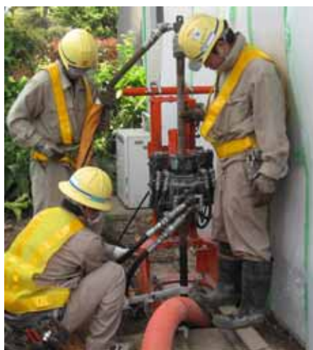
図 6.2.16 超小型の高圧噴射攪拌施工機 12)
