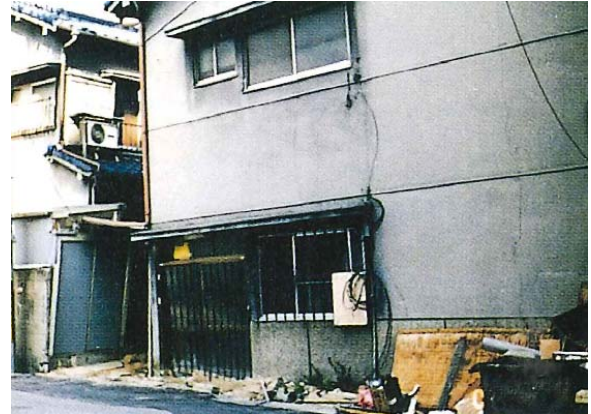
写真 3. 2. 2 建物の沈下状況
