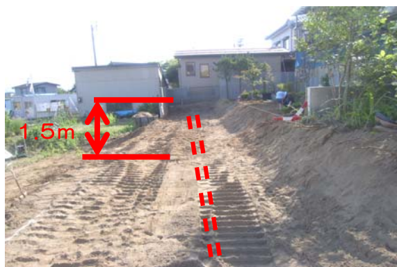
写真 3.2.116 暗渠管布設位置
