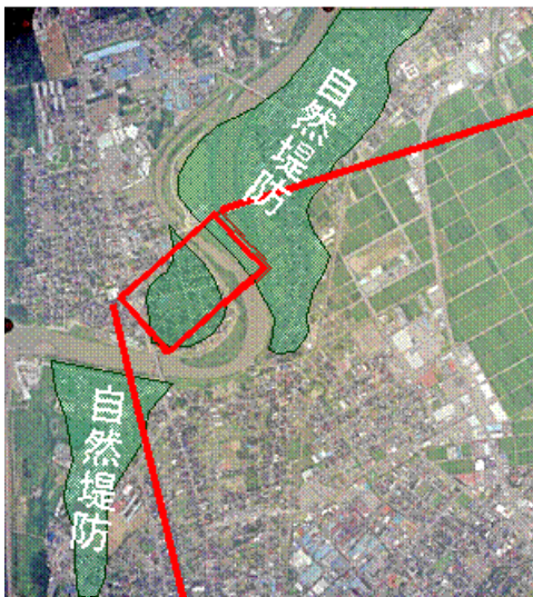
写真 3. 2. 51 地震直後の 航空写真（2007 年 7 月 19 日撮影）
