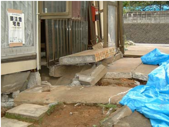
写真3.2.103 宅地内に生じた段差 (図3.2.84のPhoto(C))
