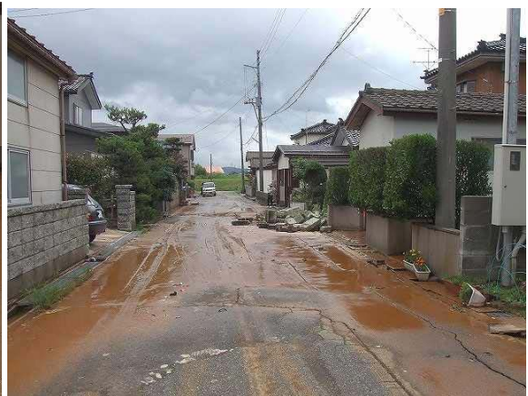
写真 3. 2. 54 道路上の泥水 (撮影地点②) (本震 40 分後)
