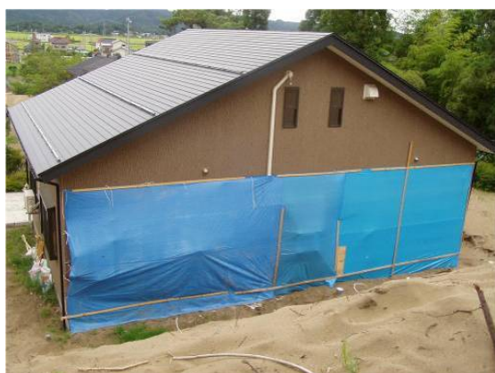
写真 3.2.13 砂丘斜面の流動による 家屋被害 2
