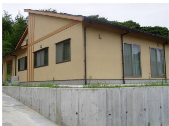
写真 3.2.14 被害が軽微であった家屋
