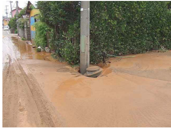
写真 3. 2. 56 道路上の泥水と電柱の沈下 1. 5m (本震 40 分後) (撮影地点④)
