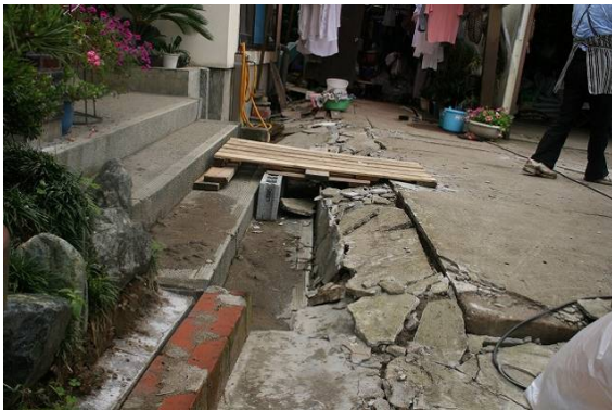
写真 3.2.30 摩擦杭支持家屋の沈下 (No. 16)
