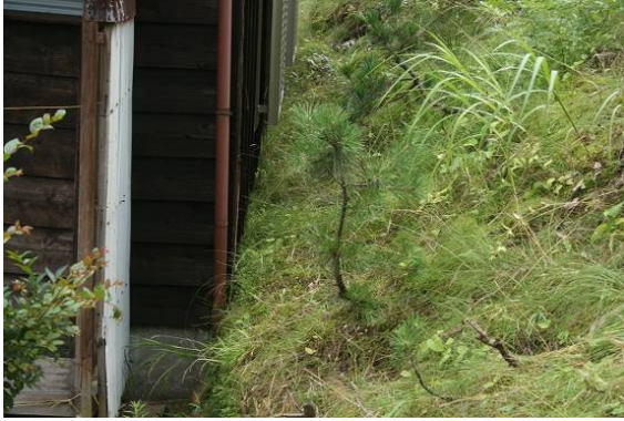
写真 3. 2. 40 斜面崩壊土の衝突 (No. X)
