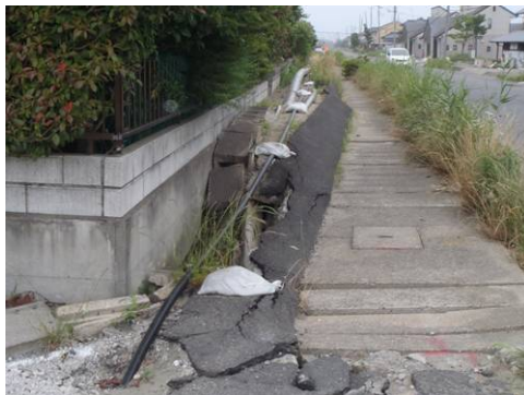
写真 3. 2. 127 ライフラインの浮き上がり現象
