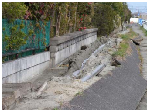
写真 3. 2. 127 ライフラインの浮き上がり現象
