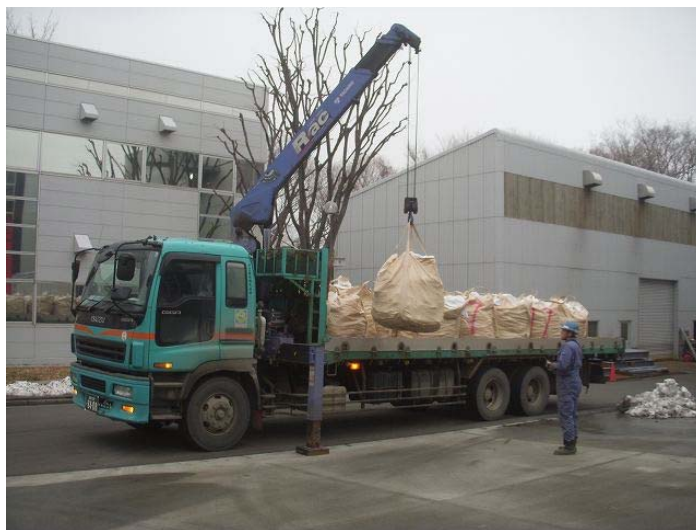
写真 7.3.2.1-1 がれき残渣の搬入時の状況
